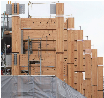
主要構造部に耐火集成木材を使用した商業施設「サウスウッド」
