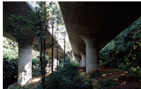
桁と橋脚を滑らかにつないだ構造が特徴の「陣ヶ下高架橋」
